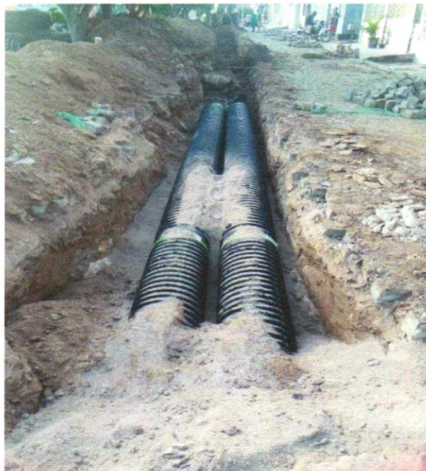
Foto 12 – FORNECIMENTO E ASSENTAMENTO DE TUBO CORRUGADO PAREDE DUPLA PEAD, D = 300 MM (12"), PARA SISTEMAS DRENAGEM, TIGRE - ADS N-12
