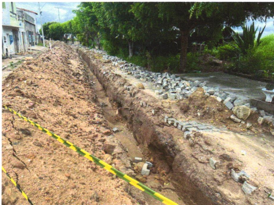
Foto 06 - ESCAVAÇÃO MECANIZADA ATÉ 1,50M EM MATERIAL DE 1º CATEGORIA PARA ABERTURA DE CORTE PARA ATERRO. SEM BOTA FORA
