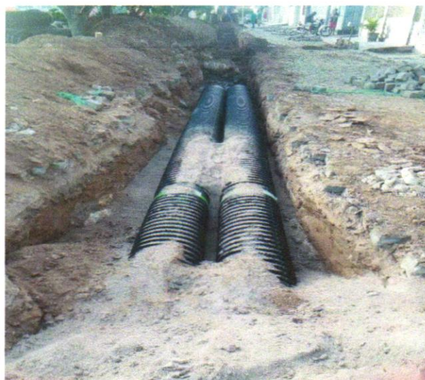
Foto 08 - ATERRO MANUAL COM SOLO ARGILO-ARENOSO IMPORTADO E COMPACTAÇÃO MECANIZADA EM CAMADAS DE 0,20 M NO MÁXIMO
