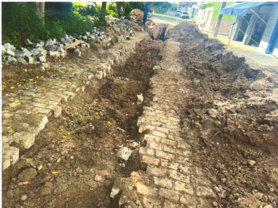
Foto 04 – ESCAVAÇÃO MANUAL DE VALA COM PROFUNDIDADE MENOR OU IGUAL A 1,30 M
