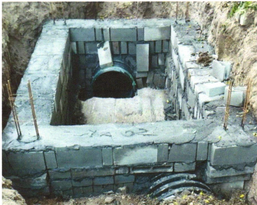
Foto 14 - FORNECIMENTO E ASSENTAMENTO DE TUBO CORRUGADO PAREDE DUPLA PEAD, D = 600 MM (24"), PARA SISTEMAS DRENAGEM, TIGRE - ADS N-12
