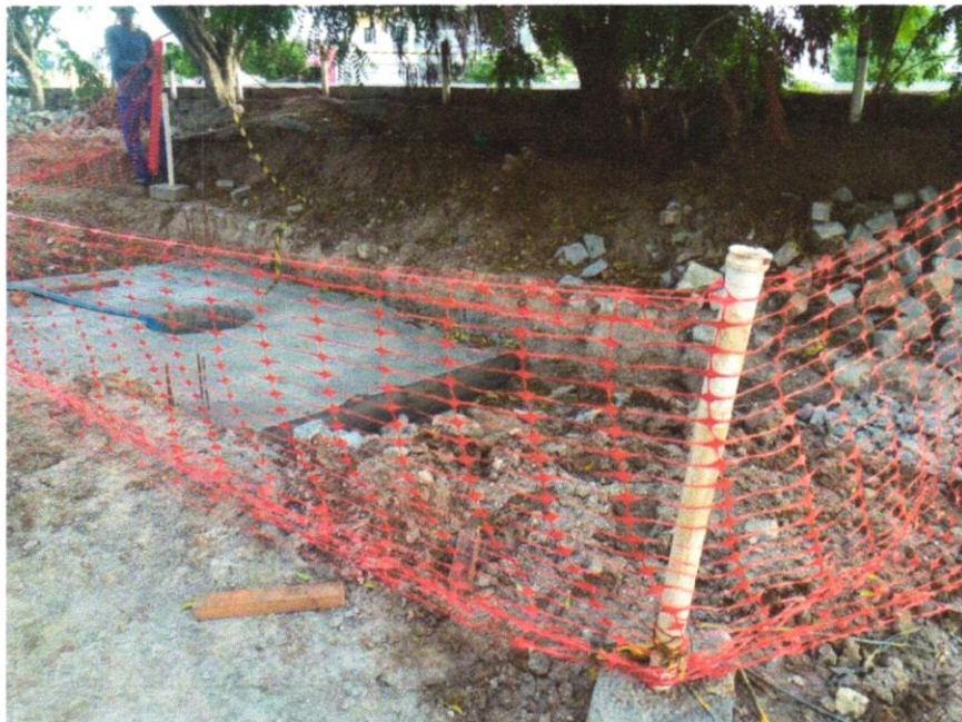
Foto 02 - Tapume de proteção em tela de polietileno h=1,20 com bloco de concreto
