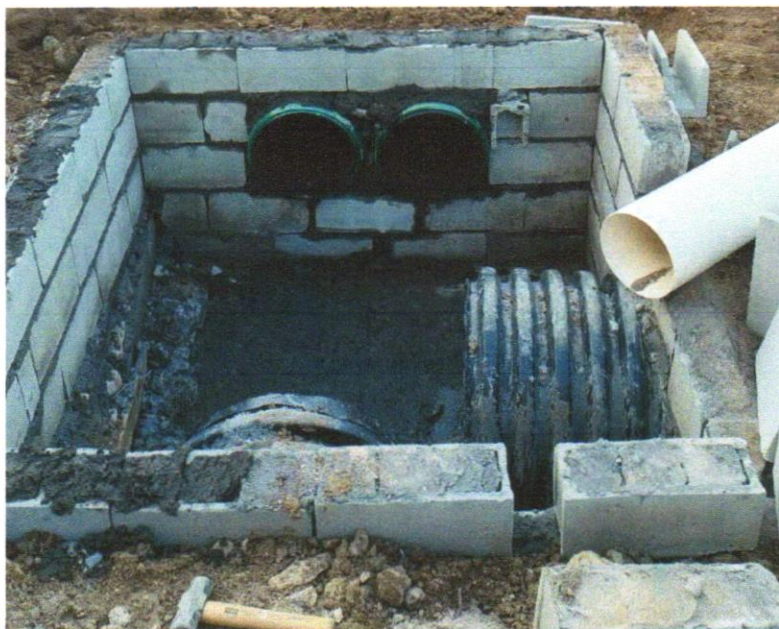
Foto 10 - ALVENARIA DE BLOCOS DE CONCRETO ESTRUTURAL 14X19X39 CM, (ESPESSURA 14 CM) FBK = 14,0 MPA, PARA PAREDES COM ÁREA LÍQUIDA MENOR QUE 6M 2 , SEM VÃOS, UTILIZANDO PALHETA. AF 12/2014
